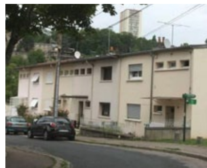
Constructions des années 1950 à Laxou
