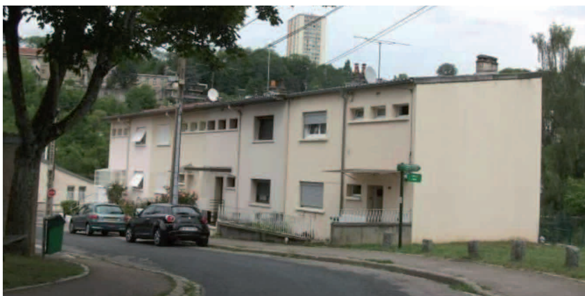
Constructions des années 1950 à Laxou
