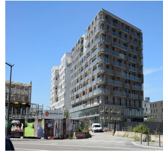
Bâtiment mixte bois et béton R+9 Quartier de la Porte de Valenciennes à Lille
